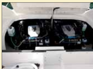
El acceso a los motores es limpio y cómodo, permitiendo realizar los trabajos de mantenimiento confortablemente.
